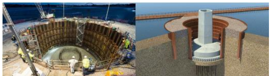
Kuva 9 Arkkupadon toteutuksen periaatekuva (Kuvan lähde Sweco (2018), alkuperäinen lähde Theconstructionindex (2018)).
