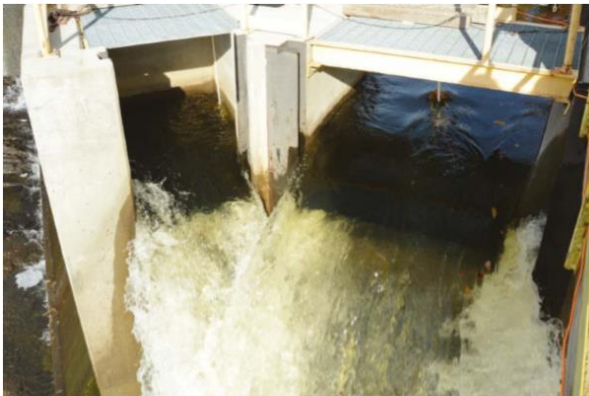
Kuva 21. Alasvaellusväylän sisäänkäynnin virtausolosuhteet ovat keskeisiä koko ratkaisun toimivuuden kannalta. Virtauksen pitää houkuttaa kala sisäänkäynnille ja lopulta estää kalan paluu takaisin ylävirtaan. Kuva: Panu Orell.
