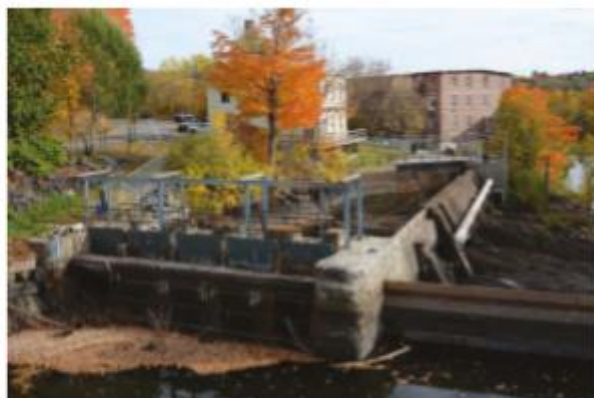
Kuva 22. Kaksi erilaista alasvaellusväyläratkaisua. Vasemmalla voimalaitoksen kylkeen rakennettu betonikouru ja oikealla putkirakenne (valkoinen putki). Kuvat: Panu Orell.
